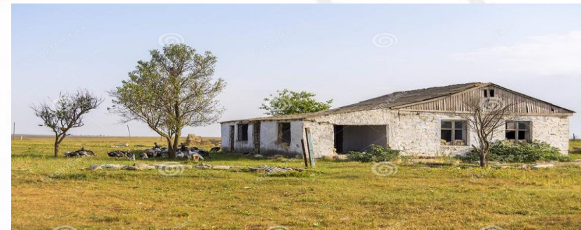
Casas en despoblado o en mal estado
