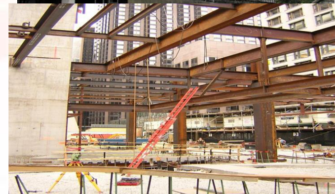
Tipos de construcción: vigas y entrepisos en ferro concreto, estructura de acero y mampostería confinada.
