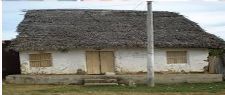
Construcciones en bahareque
